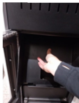
Figure 41 - dépose du bouclier de protection corps de chauffe
