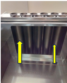
Figure 42 - Passages supérieure des fumées-échangeurs
