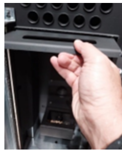
Figure 36 - Enlèvement Pare-Flamme
